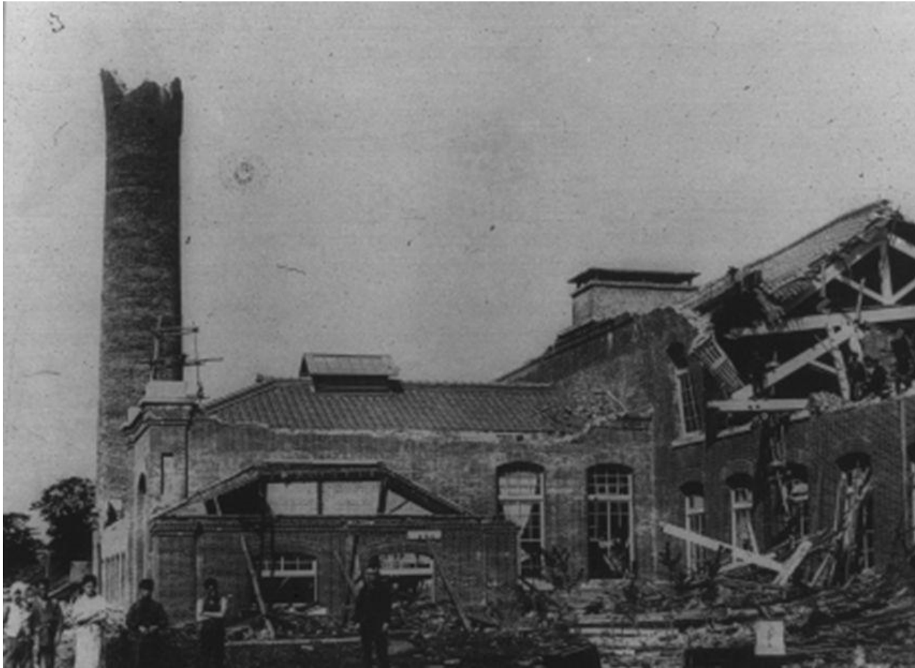
上 濃尾地震による名古屋紡績工場の被害 右上 ミルン・バートン・小川 写真集(第1版) 右下 根尾谷断層 (写真集第2版、第1版にはない)
