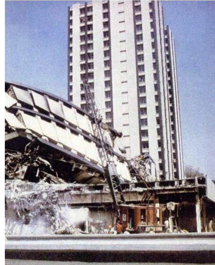
1985年メキシコ地震 21階S造政府合同庁舎の倒壊 (後ろは同じ21階建物で傾斜) 死者9500人以上
