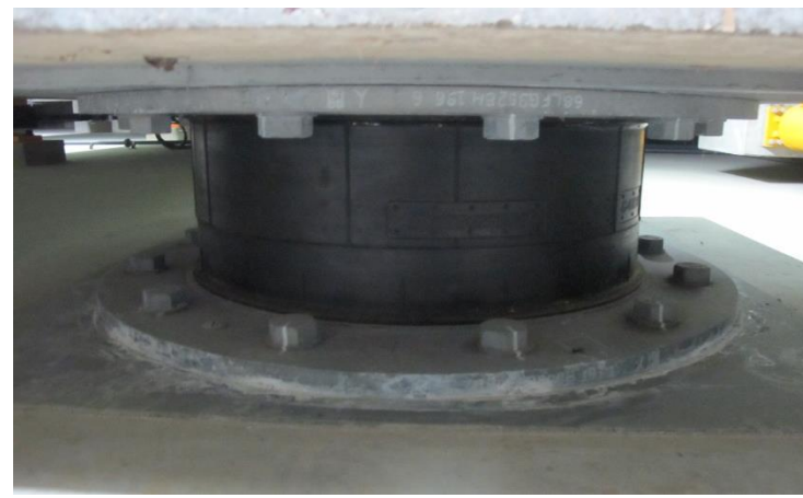
建設系新棟 上:2014年完成、RC造5階建 下:免震装置
