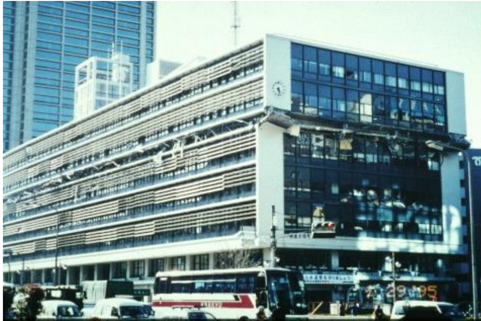
神戸市庁舎(8階建、5階までSRC、6階からRC造) 6層部分崩壊(6層より上を撤去して再使用) 新庁舎(S造30階建):無被害
