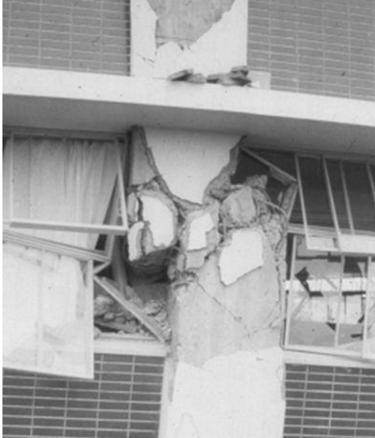
十勝沖地震による三沢高校1階柱のせん断破壊
