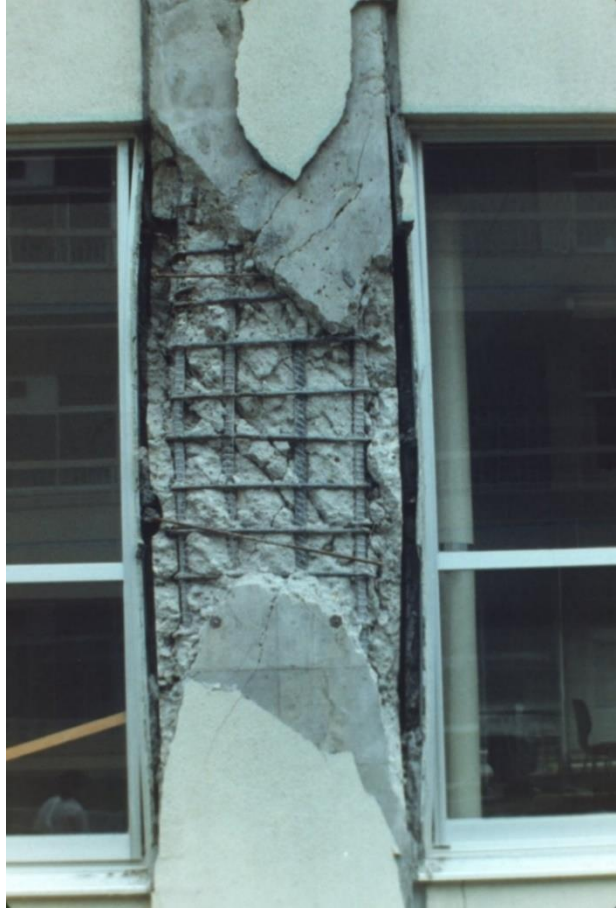
宮城県沖地震による泉高校の 1階柱被害
