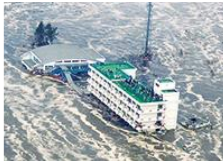
仙台市HP 仙台市荒浜小学校(RC4階建)、320人避難、全員へり救助
