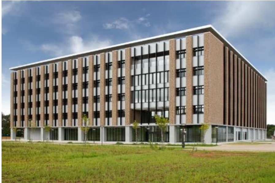
災害科学国際研究所新棟 (2014年、青葉山、免震)
